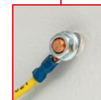
Обмедненные шпильки, закрепленный поводок заземления
